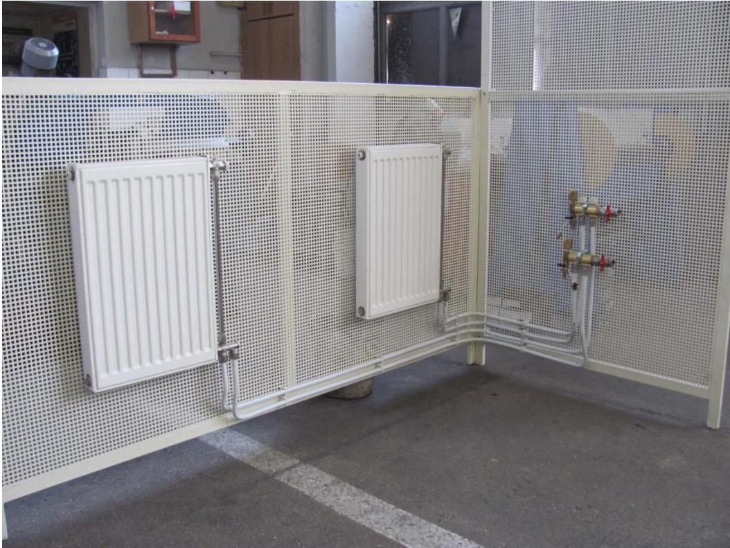
Radiátor bekötés ötrétegű műanyag csővel
