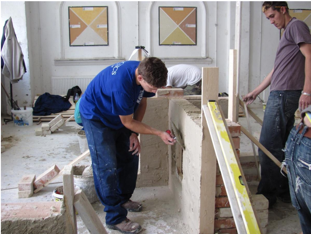
Belső vakolat felhordása
