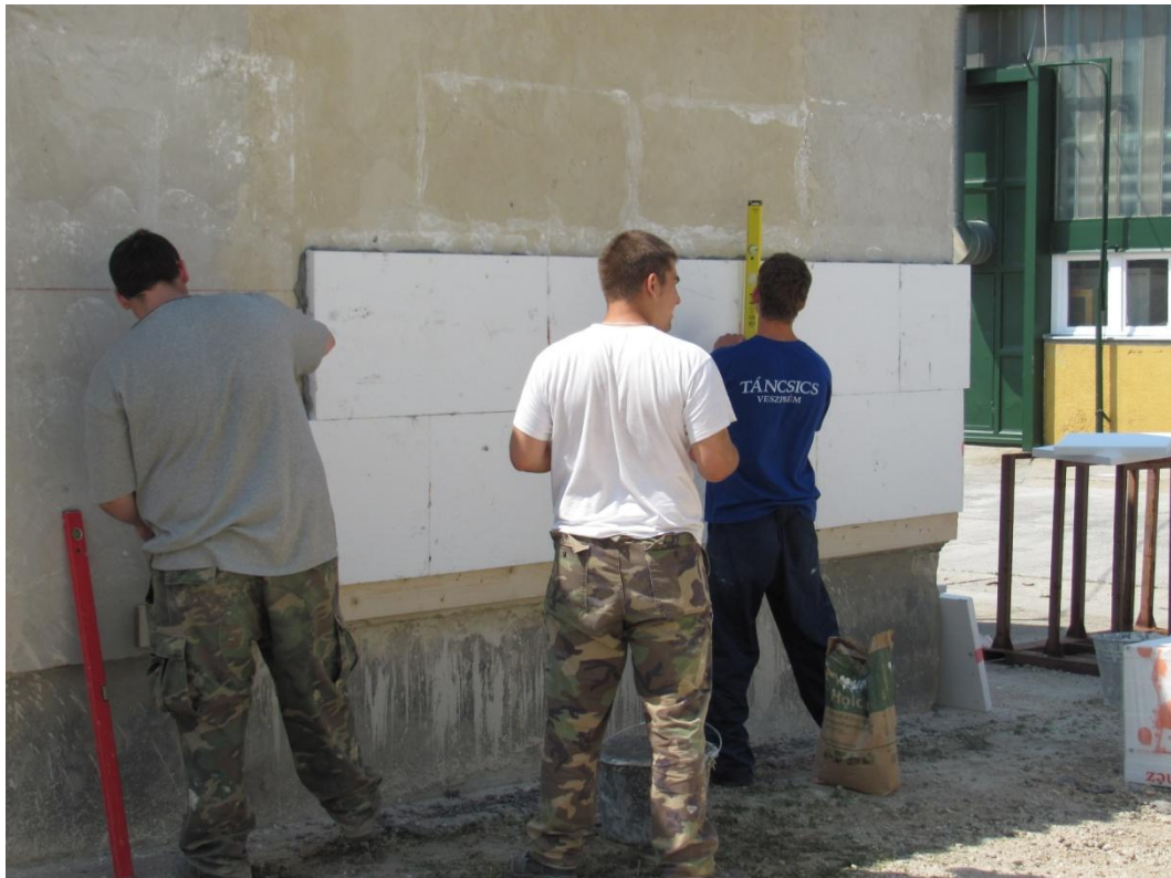
Épület homlokzat szigetelése
