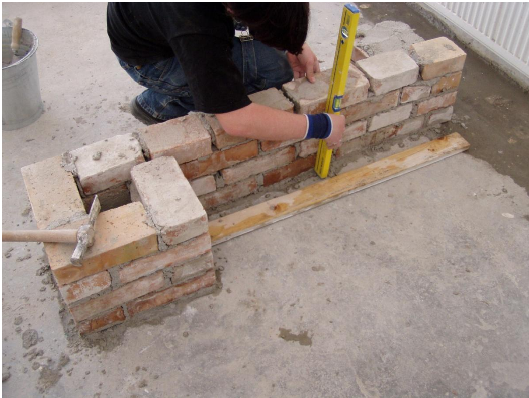
Összetett falidom készítése
