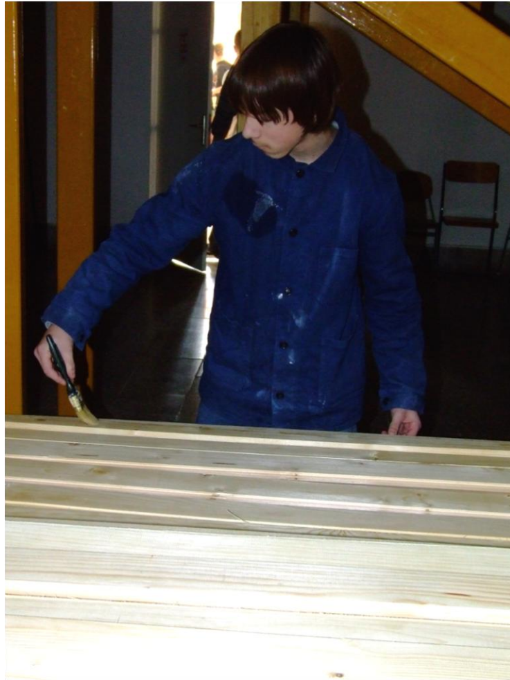
Fafelület alapozása
